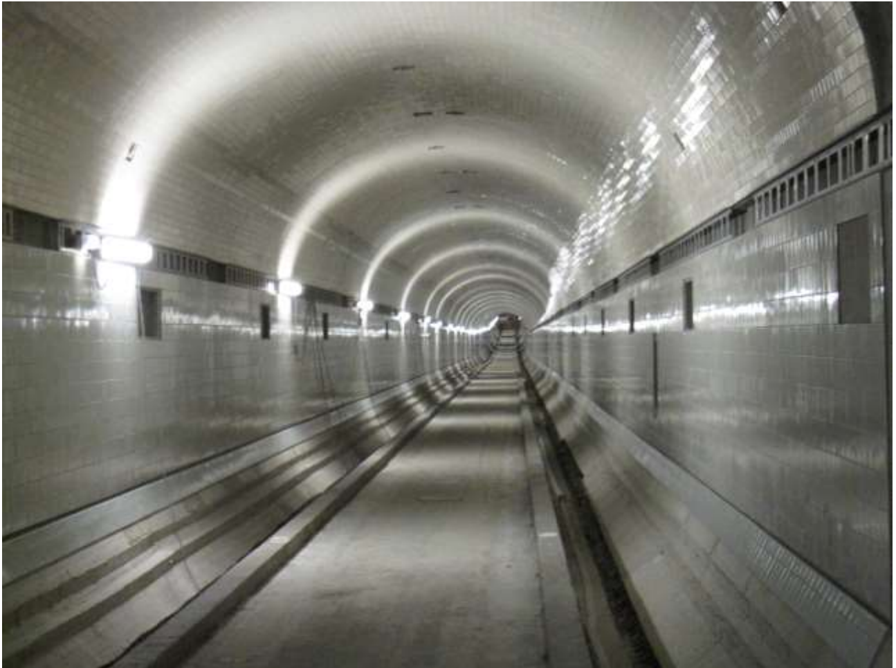
Alter Elbtunnel - Tunnelröhre im Januar 2016
